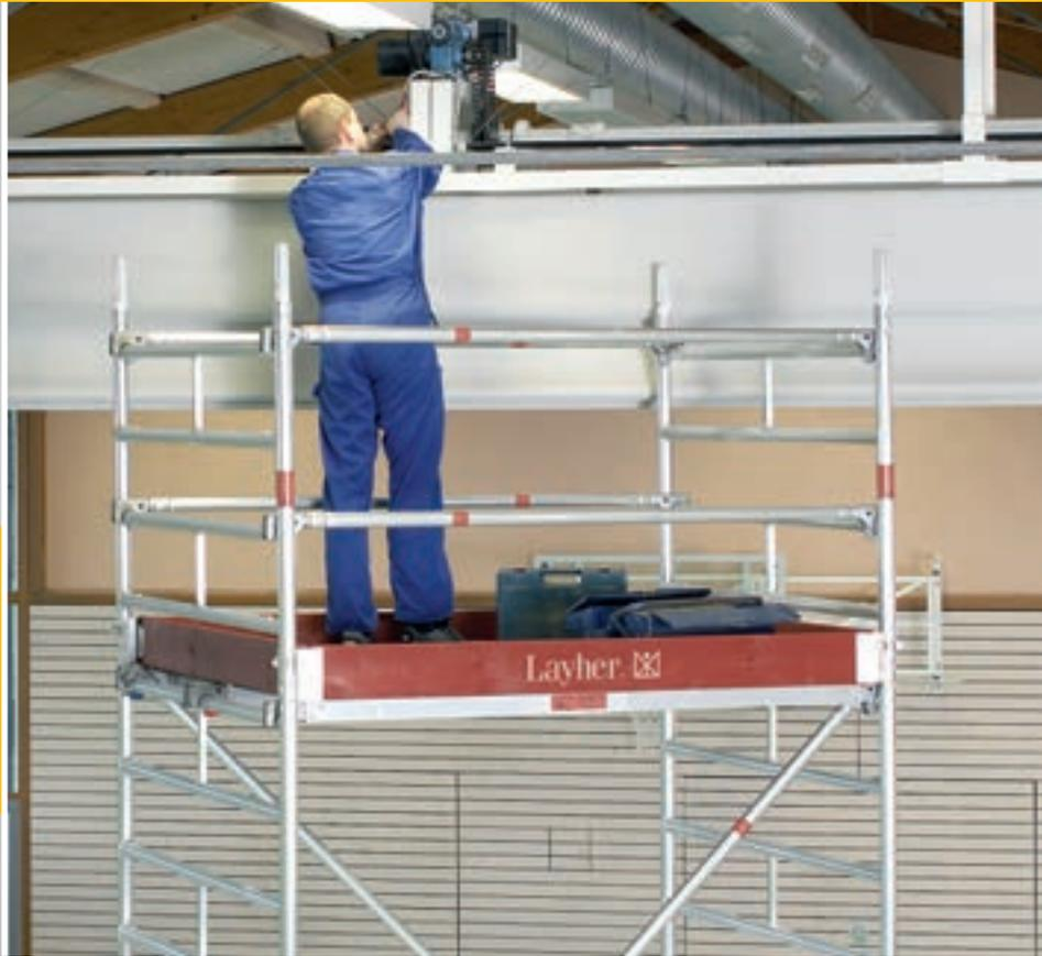
**Das Universalgerüst Uni Kompakt mit dem doppelt breiten Arbeitsboden und dennoch kompakten Grundmaßen – bietet ausreichenden Arbeitsplatz in der Höhe auch für Arbeiten mit Material und dennoch üppiger Bewegungsfreiheit.**
