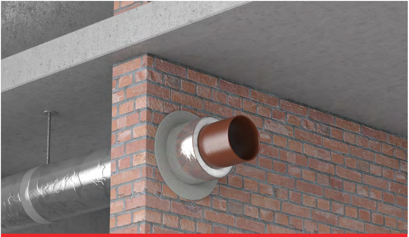
Durchführung von nichtbrennbaren Rohren nach Abschnitt 4.2 MLAR
