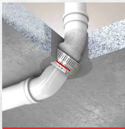
ISITHERM Rohrmanschette BBR in Massiv- decke mit 2 x 45° Bogen mit HBT Brand- schutzmörtel M3 eingemörtelt
