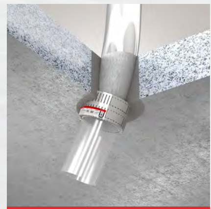
ISITHERM Rohrmanschette BBR in Massiv- decke mit Rohrpostbogen mit HBT Brand- schutzmörtel M3 eingemörtelt
