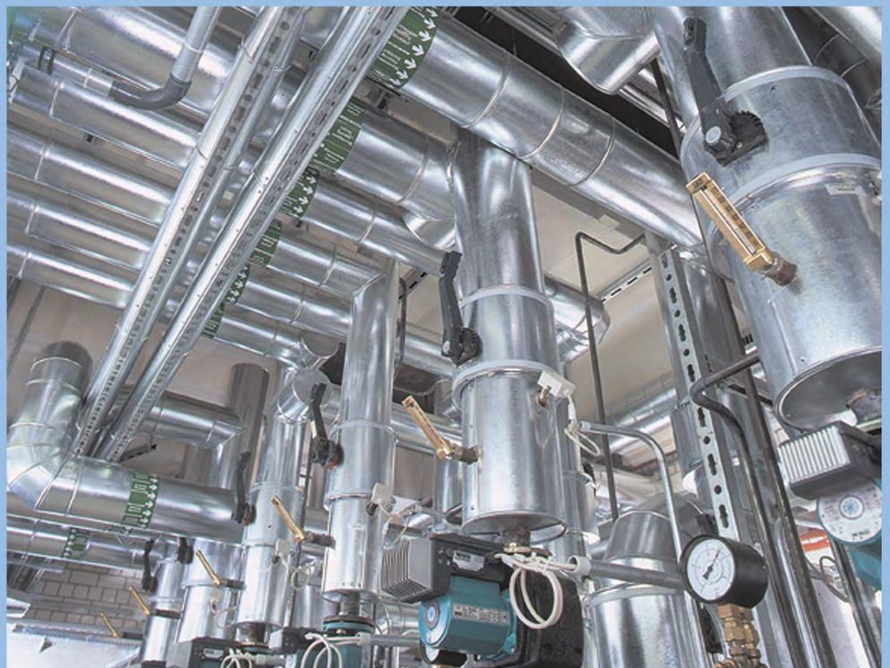
Das umfangreiche Standardsortiment, bestehend aus vorgefertigten Rohrmänteln, Bogen, Endtellern und Stutzen, kombiniert mit Kappen, Behältern etc., ermöglicht eine schnelle, kostengünstige und saubere Montage.
