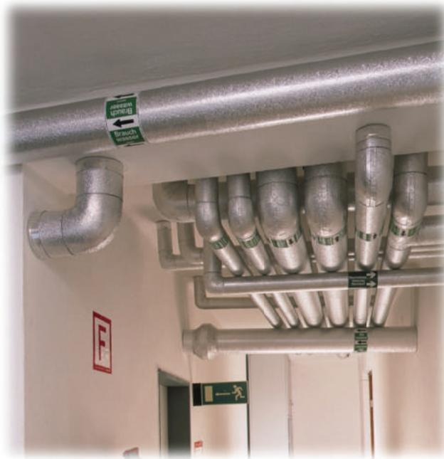
*Ummantelungssystem aus Alufolie mit Grobkornstruktur für isolierte*
