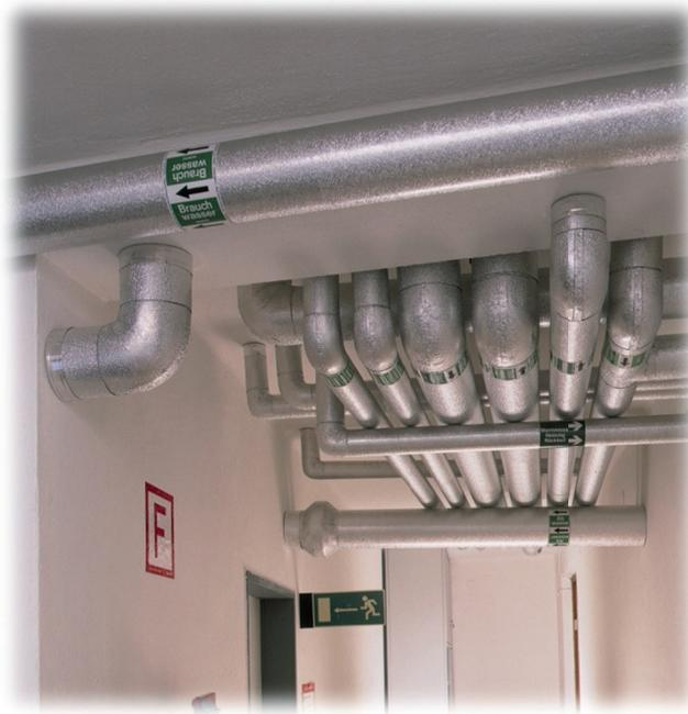
*Ummantelungssystem aus Alufolie mit Grobkornstruktur für isolierte*
