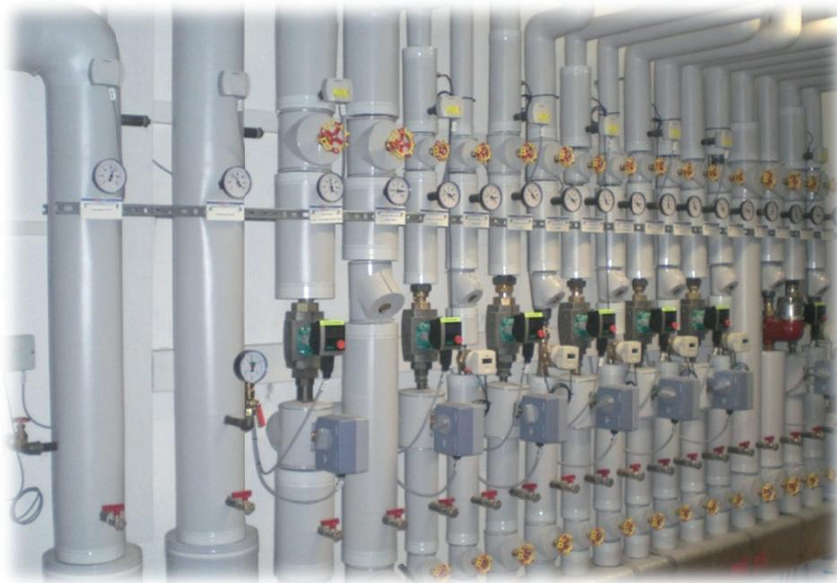
*Ummantelungssystem aus Hart-PVC-Folie für isolierte*
