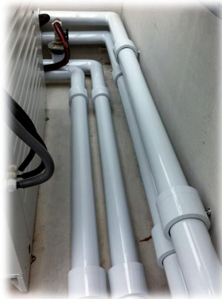
*Halogenfreies Ummantelungssystem für isolierte*
