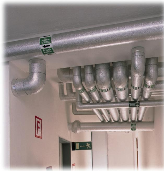
*Ummantelungssystem aus Alufolie mit Grobkornstruktur für isolierte*
