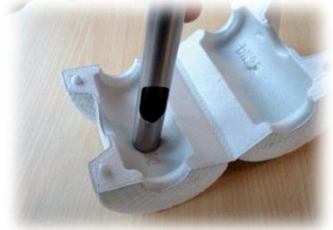
Mit der Lochpfeife oder mit angespitztem Rohrstück lassen sich (bei Bedarf) auch die Löcher für die Rohraustritte sowie den Spindelhalbs vergrößern.
