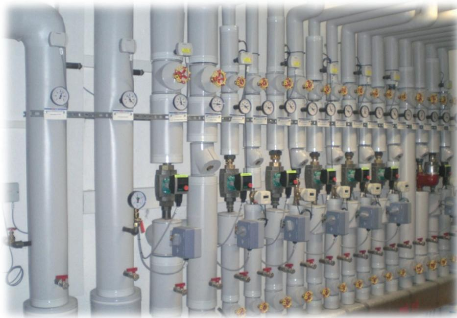
*Ummantelungssystem aus Hart-PVC-Folie für isolierte*
