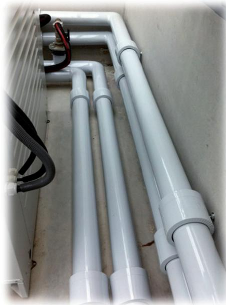
*Halogenfreies Ummantelungssystem für isolierte*
