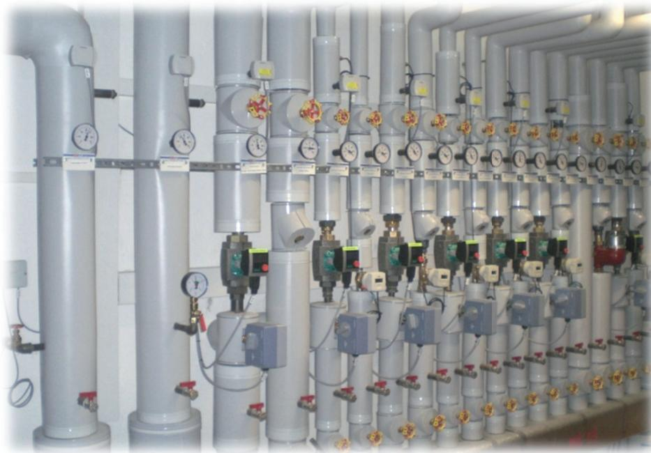
*Ummantelungssystem aus Hart-PVC-Folie für isolierte*
