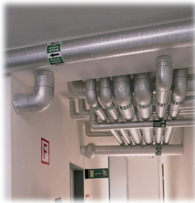
*Ummantelungssystem aus Alufolie mit Grobkornstruktur für isolierte*
