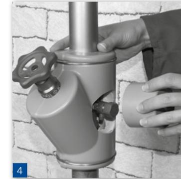
Nehmen Sie den Adapter (muss bei den Boxen ohne Entleerung separat bestellt werden) und stecken Sie ihn in das gesägte Loch.
