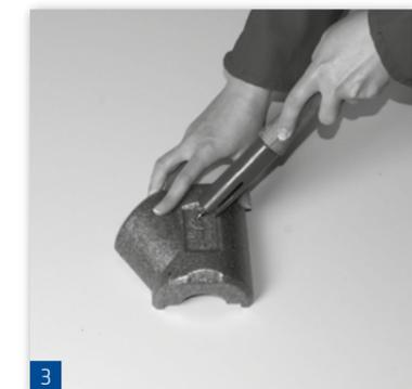
Stanzen Sie die Entleerungsöffnung mit einer Lochpfeife (alternativ mit einem Cuttermesser) aus.
