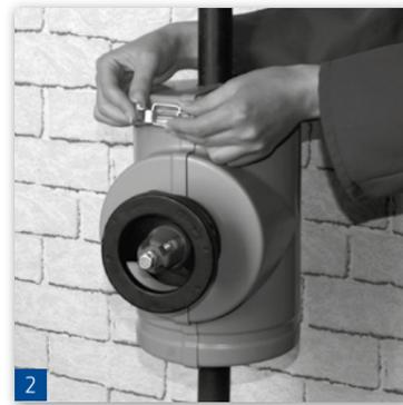
Fixieren und schließen Sie die Dämmung mit den mitgelieferten Spannbändern.
