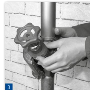
Legen Sie die erste Halbschale an und halten Sie den Adapter an seiner Position.
