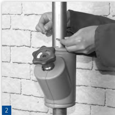
Fixieren und schließen Sie die Dämmung mit den mitgelieferten Spannringen.
