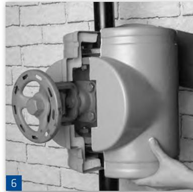
Klemmen Sie die Halbschalen an die Armatur und befestigen Sie entsprechend unserer Montageanleitung mit den mitgelieferten Spannbändern.
