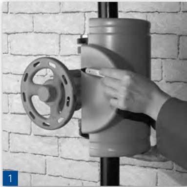
Legen Sie die Halbschale an die Armatur und markieren Sie die Spindelmaße auf der Außenschale.
