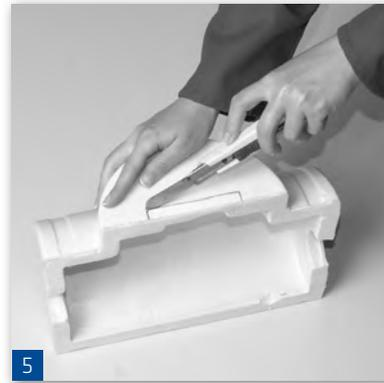
Übertragen Sie den Ausschnitt der PS-Schale auf den Schaumkern und schneiden Sie mit einem Cuttermesser entlang der Markierung.
