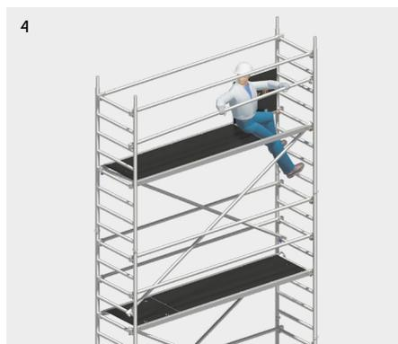
Montage der Zwischengeländer aus gesicherter Position im Bereich der Durchstiegsklappe.
