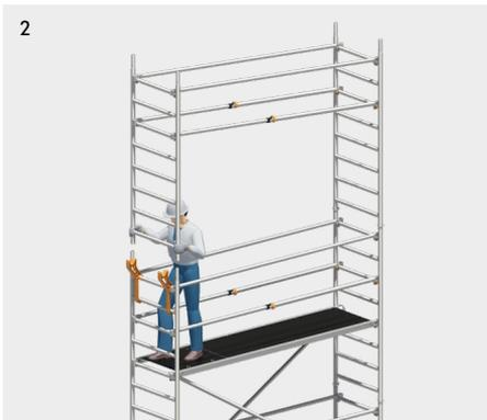
Standleiter mit Geländern und Uni Telegeländern nach oben schwenken und aufstecken.
