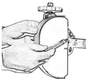
**3.** Liegt die Baulänge der Kappe fest, können die Öffnungen für den Rohraustritt in die Deckelhälften mit Hilfe einer Blechschere (IDEAL- oder Lochschere) geschnitten werden. Hierbei ist zunächst anhand **einer** Deckelhälfte, die man zur Armatur hält, zu prüfen, wie der Armaturenkörper in der Kappe zu liegen kommt.
