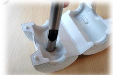
Mit der Lochpfeife oder mit angespitztem Rohrstück lassen sich (bei Bedarf) auch die Löcher für die Rohraustritte sowie den Spindelhals vergrößern.
