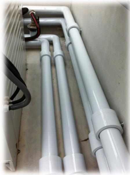
*Halogenfreies Ummantelungssystem für isolierte*
