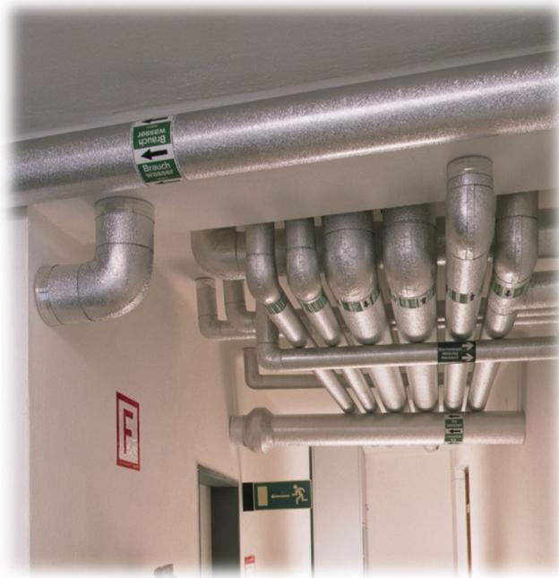
*Ummantelungssystem aus Alufolie mit Grobkornstruktur für isolierte*
