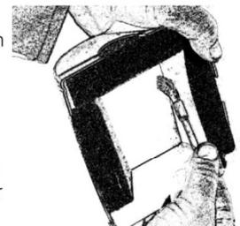
**9.** Die mit Dämmstoff gefüllten Kappenhälften werden an der Armatur derart zusammen geführt, dass die Kappenteile bis zum vorgesehenen Anstoss überlappen. Mit Hilfe der mitgelieferten Befestigungsbänder und Klemmhebelschlösser wird die Kappe in Position gehalten.
