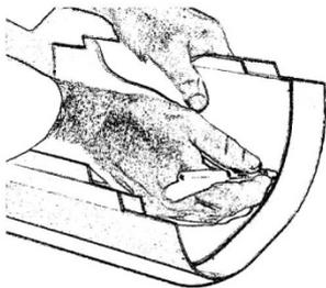
**1.** Zunächst wird der Kappenmantel an die notwendige Isolierlänge der Armatur angepasst. Diese Baulänge der Kappe hängt davon ab, ob und wie weit die Kappe die angrenzende Rohrisolierung überlappen soll. Mit Hilfe einer stabilen Schere (besser: Blechschere) kann der Kunststoff-Kappenmantel nach Bedarf gekürzt werden, wobei
